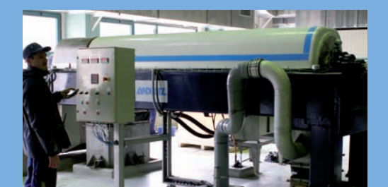
Les centrifugeuses déshydratent les boes issues des digesteurs.
