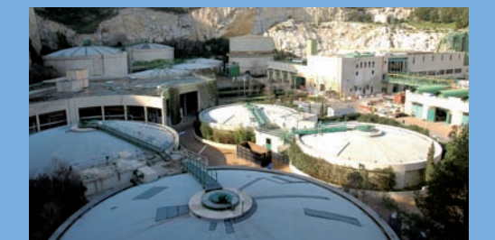
Batterie d'épaisseurs et de digesteurs sur le site de la Cayolle.
